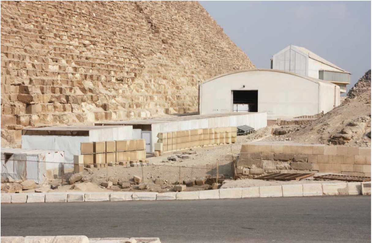
図2 現場遠景 (かまぼこ型の建物がピットと作業場を覆う大テント倉庫)
